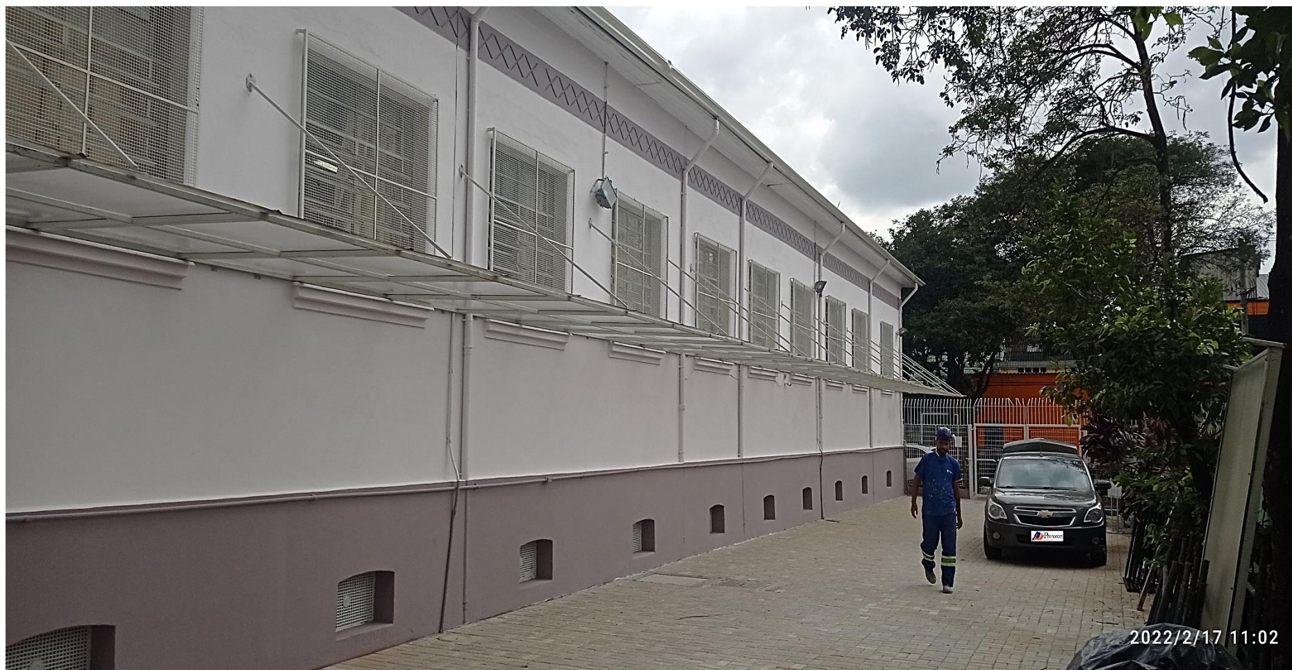
Fachada da Escola após a execução dos serviços de tratamentos de manifestações patológicas e reinstalação da cobertura metálica externa.
